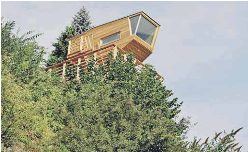
Schwerlastgurte, Drahtseile und eventuelle Stützen halten das Baumhaus. Als Fundament kommt fast jeder Baum in Frage.
