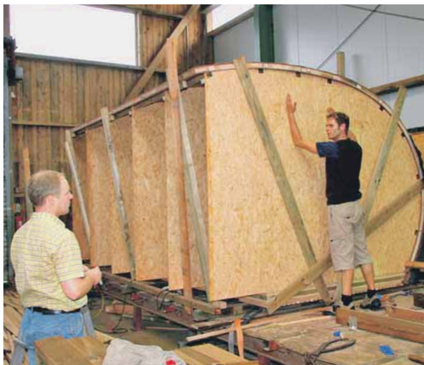
Die Werkstatt in der Zimmerei Schorling: Hier werden die Baumhäuser akribisch vormontiert.
