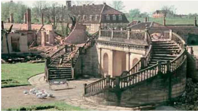
Nach der Bombardierung des Schlosses 1943 blieb lediglich die Freitreppe erhalten.
