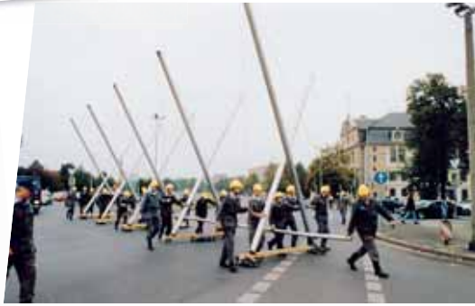
1970: Aufwändiger Aufbau von Snelsons Objekt.
