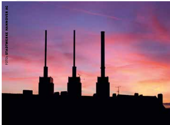
Ein Wahrzeichen Hannover-Lindens: Die „warmen Brüder“, das Heizkraftwerk der Stadtwerke Hannover AG.
