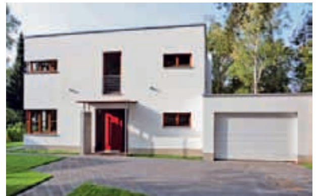
Das Eigenheim im Bauhaus-Stil: Haus „Weimar“.
