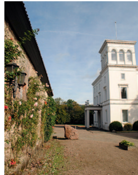
Hofgelände: Links steht der ehemalige Rinderstall, im Hintergrund das Herrenhaus
