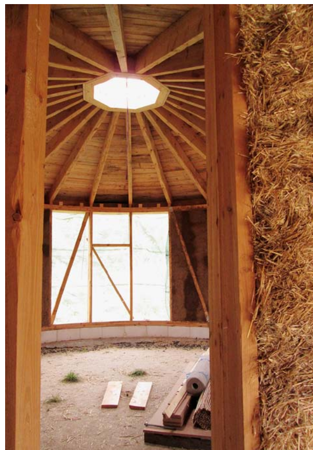
Das „Haus der Stille“ wird wie die Wohngebäude mit Strohballen gedämmt. Es soll bald allen Bewohnern und Gästen zur Verfügung stehen.
