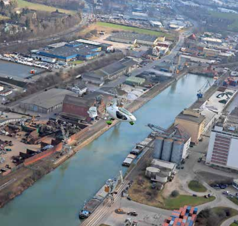
Kontrolle aus der Luft., z. B. von Industrieanlagen
