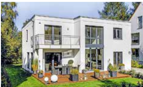
Individuelle Wohnräume, von Fischer-Bau realisiert.
