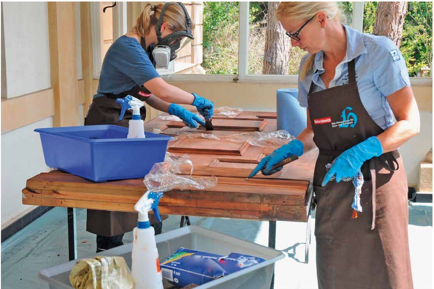
Lackabnahme an einer großen Kassettentür.
